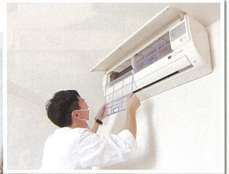
エアコンフィルター交換
